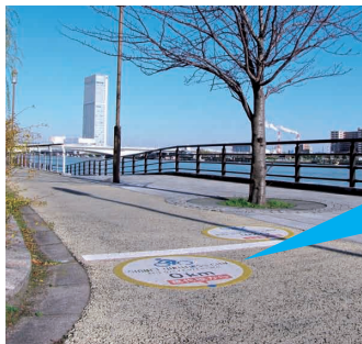
写真-4 距離標の設置状況
